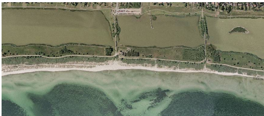
Figur 13.0, Onduleringer af kyst ved de to østligste adgangsbroer til strandparken.
